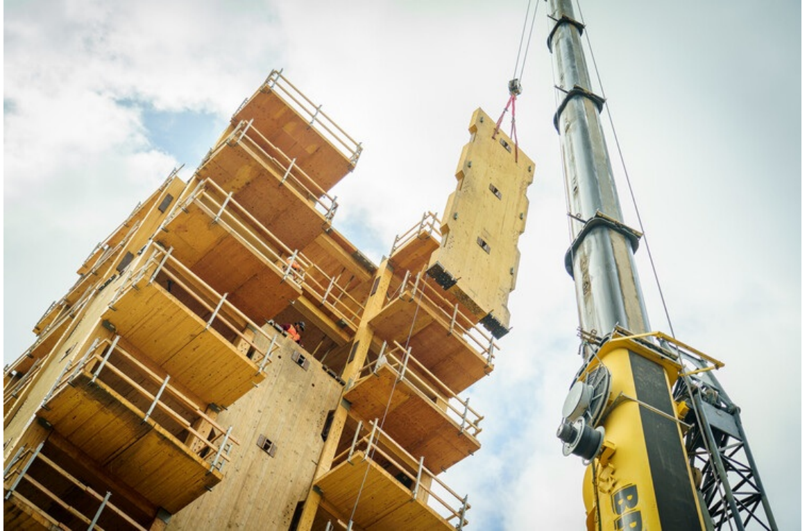
En esta foto vemos el izado de uno de los paneles del muro central colocado entre las dos filas de balcones del edificio. Este panel central tiene un espesor de 400 mm, formado por 7 capas de madera
